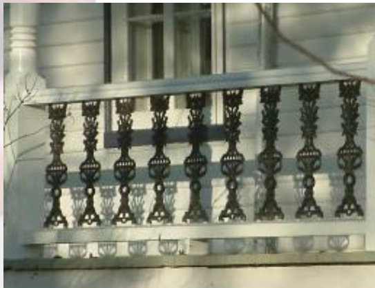
Garde-corps en fonte moulée
